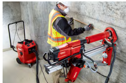
Perforadora de diamante DD250-CA con unidad de reciclado de agua y Cut Assist incorporado.
