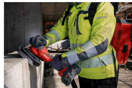
Realización de chaflán con la DGH130-22 a batería y aspirador VC4.
