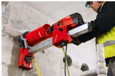
Perforadora DD160 perforando a pared con el sistema de recolección de agua.
