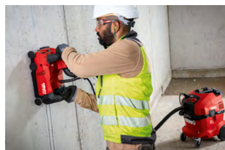
Rozadora de diamante DCH150 con aspirador abriendo rozas a pared sin polvo ni grietas.
