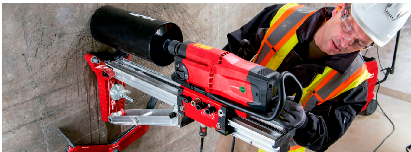
La DD250 en una taladro a muro con sistema de reciclado de agua Hilti WMS100.
