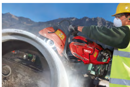
Cortadora de gasolina DSH900 cortando una tubería de hormigón de 15cm de profundidad.
