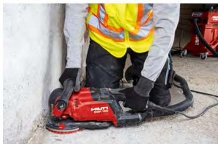
Desbaste a ras con la DGH150 con la carcasa abierta.
