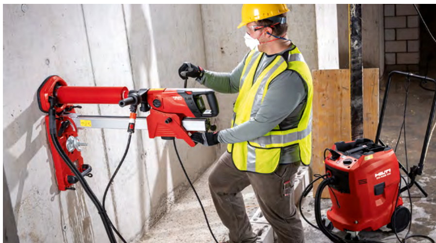
La DD150 taladrando hormigón armado a pared hasta diámetro de 132mm de broca.
