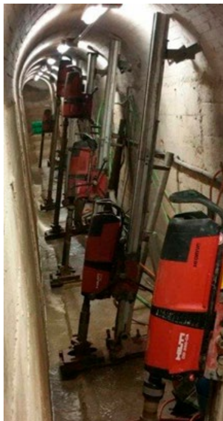
Perforadoras de diamante Hilti DD 350-CA taladrando en la galería de la presa.
