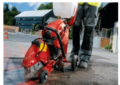
La DSH 900 cortando sobre el carro cortasuelos DSH-FSC.
