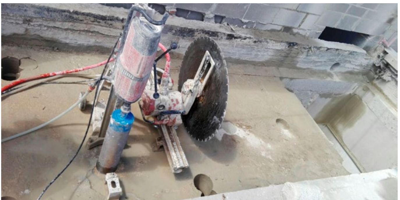
Corte de los huecos de montacargas con perforaciones de diamante para evacuar las piezas.
