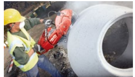
La DSH 900 corta tubos de hormigón hasta 15 cm de profundidad.
