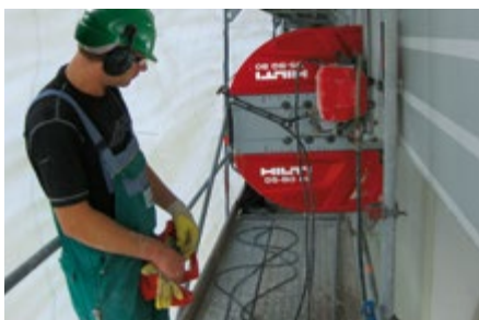
Corte de balcones en rehabilitación
