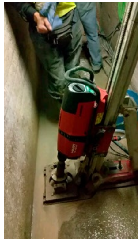
Grupo 5 desarrolló un sistema propio de guía de centrado para asegurar la perpendicularidad del taladro.
