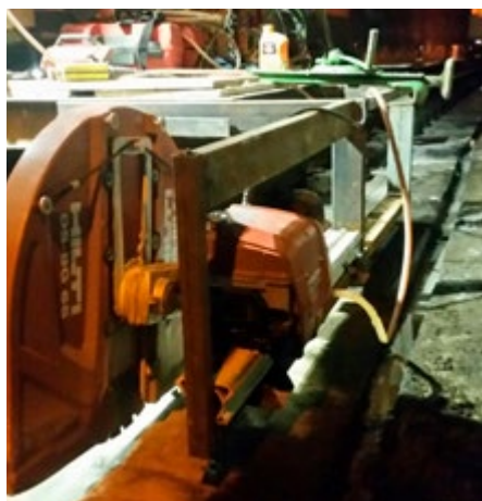
Una de las dos cortamuros eléctricas DST 10 cortando traviesas.
